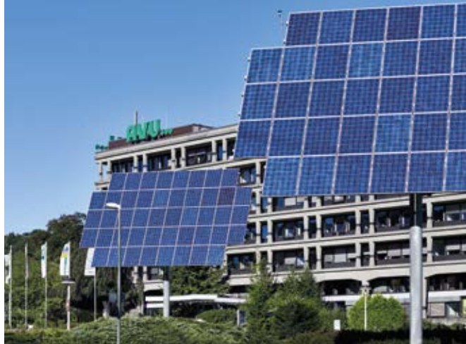
Ziel mehr Erneuerbare Energien: Die AVU unterstützt Unternehmen bei der Installation von Photovoltaik-Anlagen
